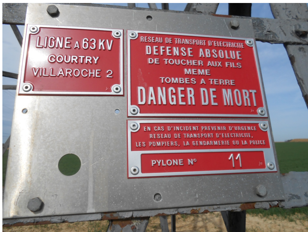
Vue du support n° 11 et repère physique de proximité
