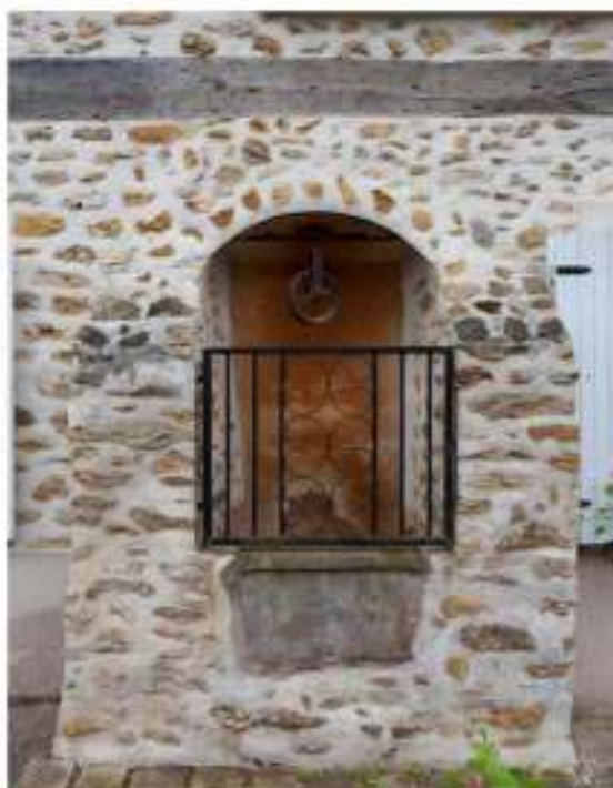
Puits rue du Mont
