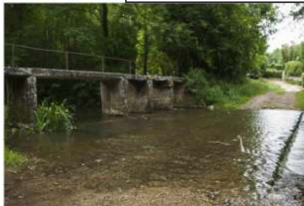
Pont du Moulin de Pouilly
