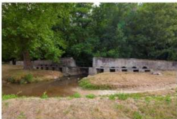
Pont de fer
