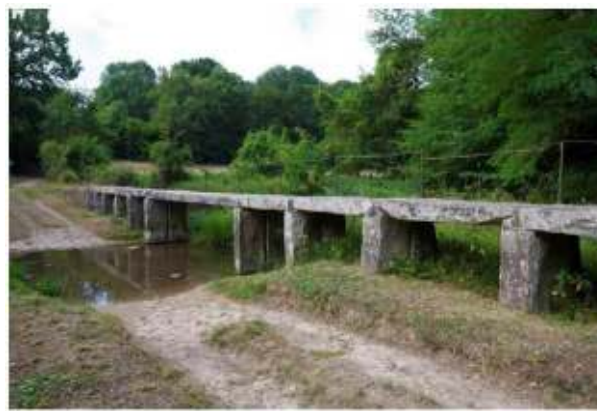
Pont du Moulin de la Roue
