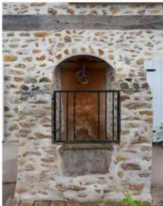
Puits rue du Mont
