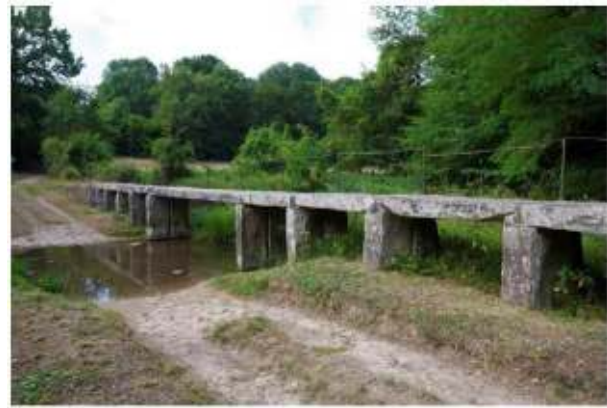
Pont du Moulin de la Roue
