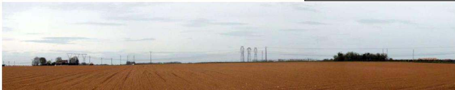
Un espace sillonné par un couloir de lignes à hautes tensions. Des bosquets et arbres isolés ponctuent l'horizontalité du paysage.
