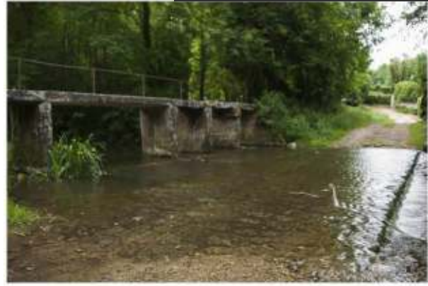
Pont du Moulin de Pouilly
