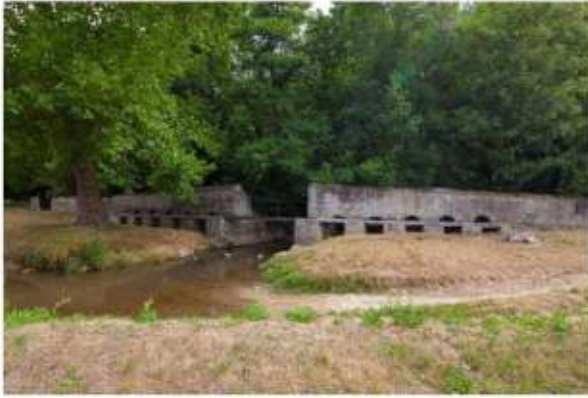
Pont de fer
