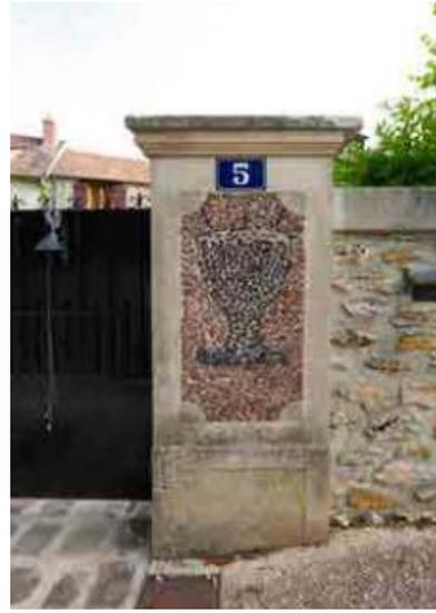
Décors figuratifs meulière, brique et silex. Maison typique des XVIIIème et XIXème siècles. La technique de fabrication des murs en meulière et des décors est le joint par rocaillage. Il faut réaliser un jointoiment de chaux dans lequel on a inséré des fragments de meulière, de briques, d'ocre ou de terre de Sienne, pour que le joint soit coloré.
