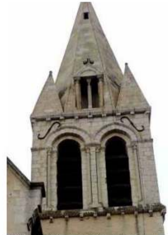
L'église Saint-Martin. Le beffroi et la flèche du clocher.
