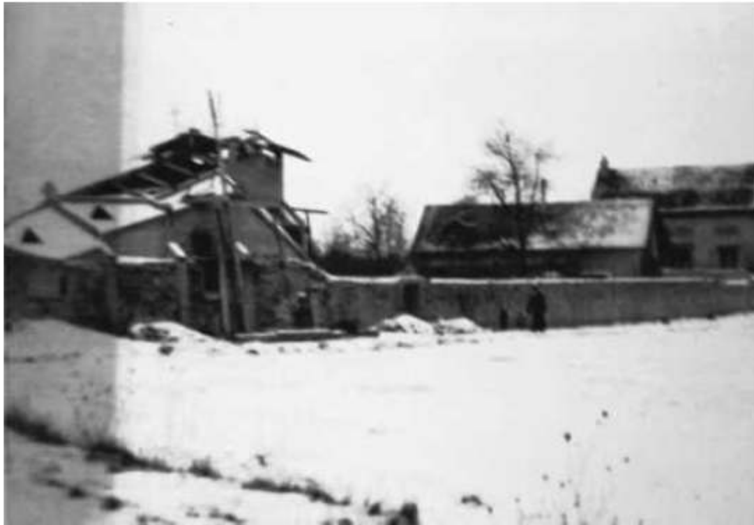
Ermitage de Notre-Dame de Kazan, Moisenay, église en construction, avant 1962, tiré de http://skite-notredame-de-kazan.blogspot.fr
