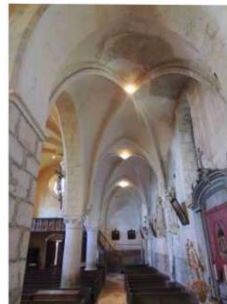
L'église Saint-Martin. Le bas-côté nord.
